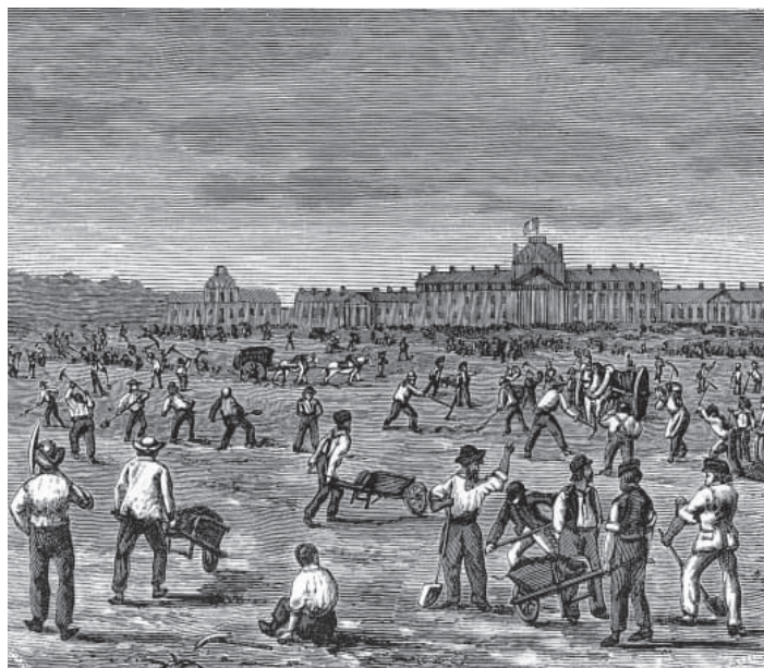
08. Terrassement du Champ-de-Mars par les ouvriers des Ateliers nationaux
