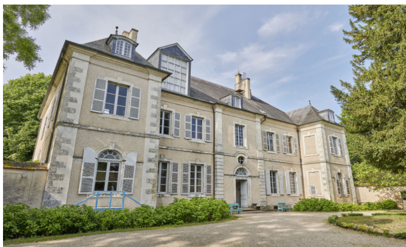
Maison de George Sand © Benjamin Gavaudo - CMN
